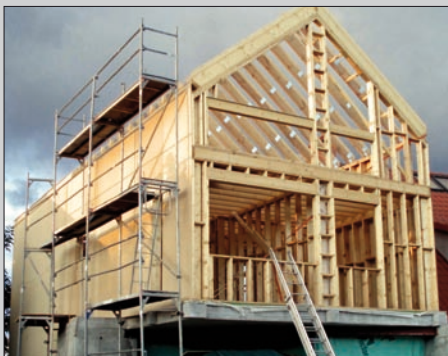
Budowa - wykonanie szkieletu drewnianego
