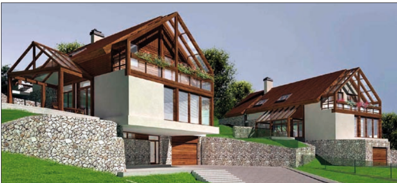
Rezydencje na stoku. Architektura w grze kompozycyjnej z konstrukcją; składowe konstrukcje w roli kreatorów formy i detalu
